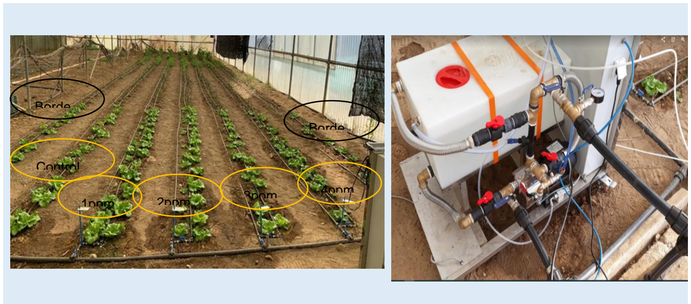
Figura 43. Conexión del generador de ozono al sistema de riego del invernadero
