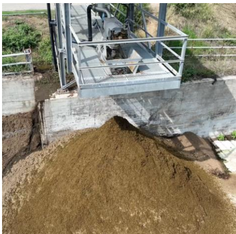
Separador de fracción líquida y fracción sólida de los purines.
